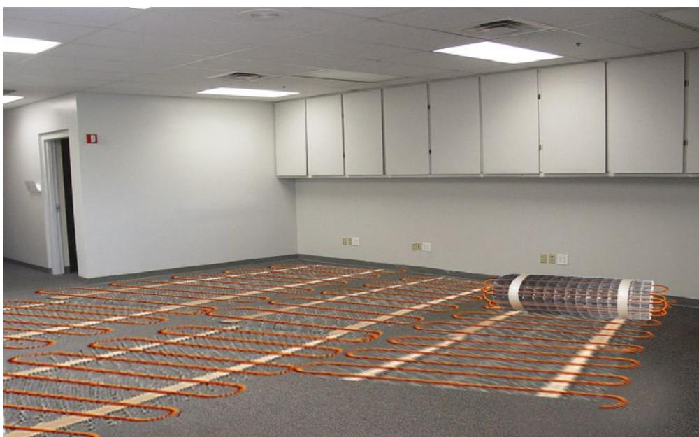
Температура системы обычно устанавливается термостатом и контролируется установленными в комнате датчиками для поддержания температуры поверхности 21–24 °C (70–75 °F) и температуры под поверхностью 24–28 °C (75–82 °F).
